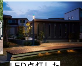
LED点灯した 『Smart Pole』
